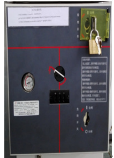
挂锁闭锁接地开关
